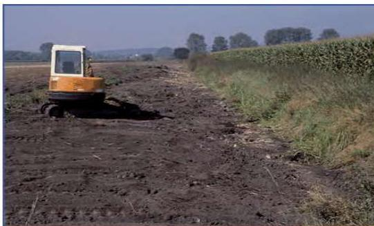
Abb. 34: Einseitige Abflachung eines Entwässerungsgrabens in der Brenzaue.
